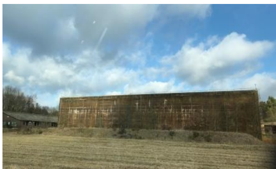
Abbildung 8: Ehemaliger (Atomwaffen-) Bunker im Südosten des Plangebiets
