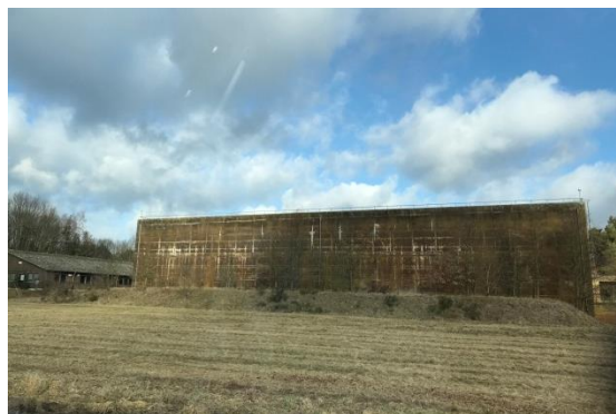
Abbildung 7: Ehemaliger (Atomwaffen-) Bunker im Südosten des Änderungsereichs
