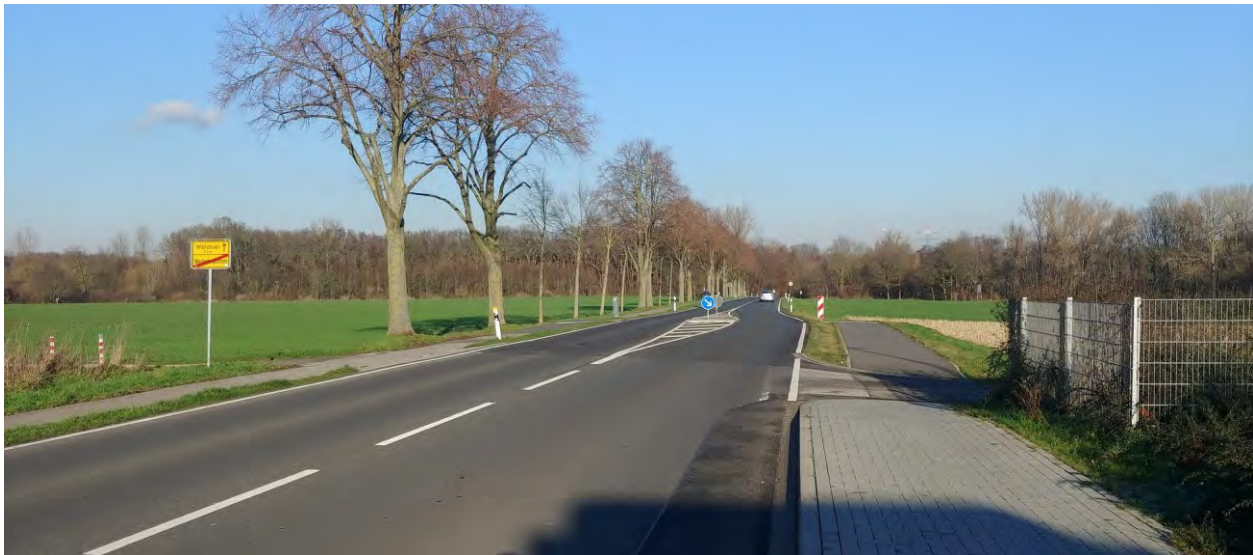
Abbildung 12: Hochstraße in Richtung Osten im Bereich der geplanten Erschließung
